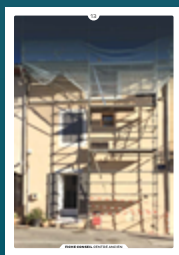
13 les modifications de baies
