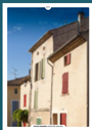
01 les façades enduites
